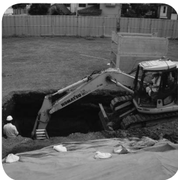
1. 試掘坑の設定。 掘削は重機を使用。
